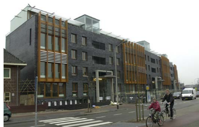
Op deze locatie verrees in 2000 een appartementencomplex.
