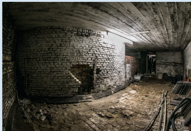
Dit is een van de oudste stukjes Breda: de voet van 1 van de 2 torens van de Tolbrug in de kelder van monument 'de Trapkes'.
