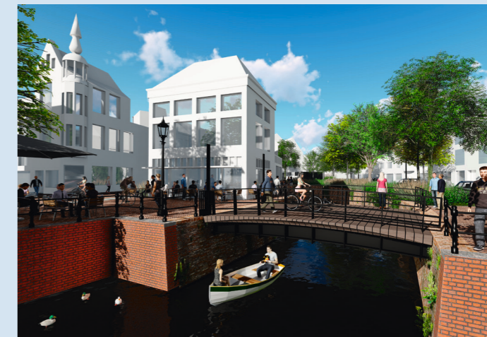
In dit voorlopig ontwerp van de nieuwe Tolbrug (planning 2021) stroomt het bevaarbare water van de Mark weer door de stad. Het wordt een licht gebogen, houten brug voor langzaam en bevoorradingsverkeer.
