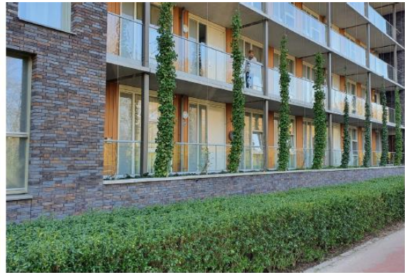
Alzijdigheid - galerij onderdeel gevel
