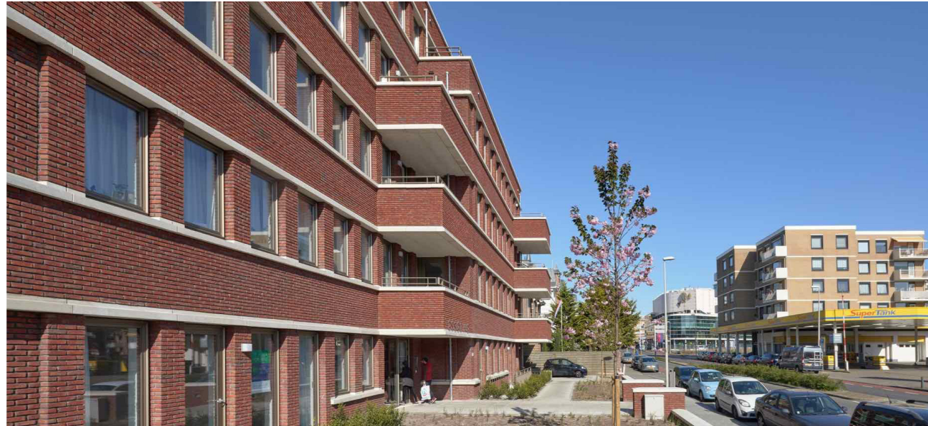
Appartementen in jaren '30 stijl
